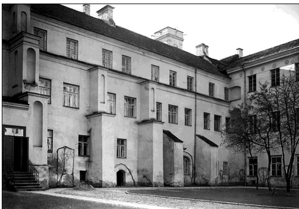
Południowe skrzydło (biblioteczne) Dziedzińca Sarbiewskiego po pracach remontowych w 1929 r. Fotografia Jana Bulhaka z 1929 r.
