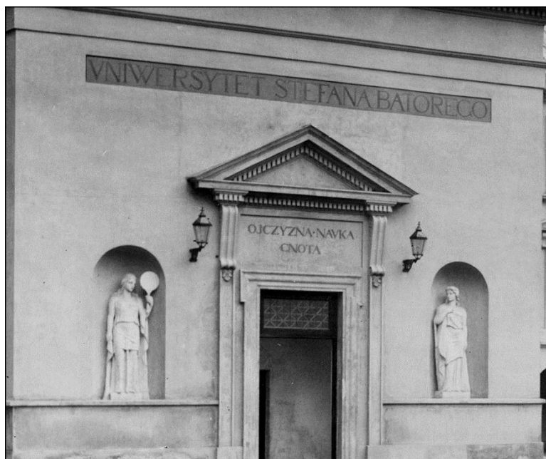
Fasada z wejściem do Auli Kolumnowej po remoncie w 1929 r. Widoczne są dwie tablice oraz posągi wykonane przez B. Bałzukiewicza. Fragment fotografii z 1930 r., wykonanej podczas kursu społeczno-oświatowego dla nauczycieli ziemi wileńskiej, którego obrady odbywały się na terenie USB. (Źródło: NAC, sygn. PIC_1-N-1333).
