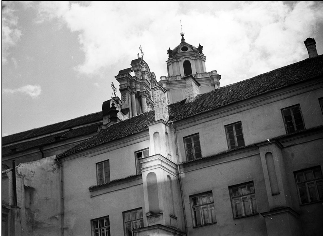
Południowe skrzydło Dziedzińca Sarbiewskiego po remoncie w 1929 r. Fotografia Jana Bułhaka z 1935 r. (Źródło: NAC, sygn. PIC_1-U-7679-3).
