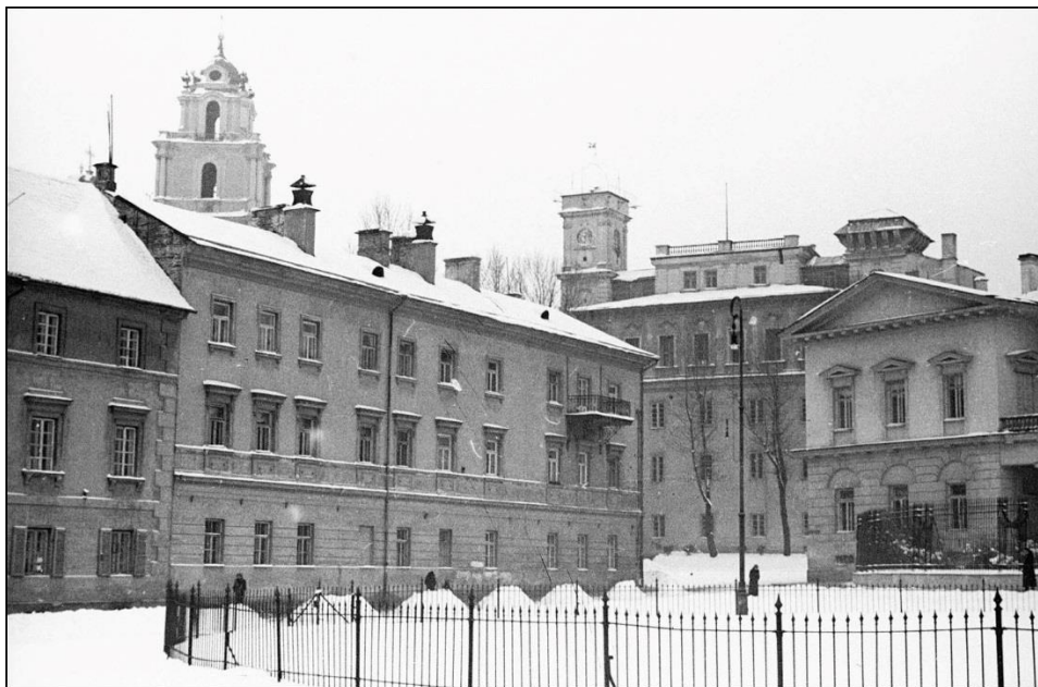
Budynek zajmowany od 1919 r. przez Wydział Teologiczny USB przy ulicy Uniwersyteckiej 7. Na drugim piętrze jednego z mieszkań zamontowany został balkon. Fotografia H. Poddębskiego z 1937 r. ( Źródło: NAC, sygn. 3/131/0-/531/26).
