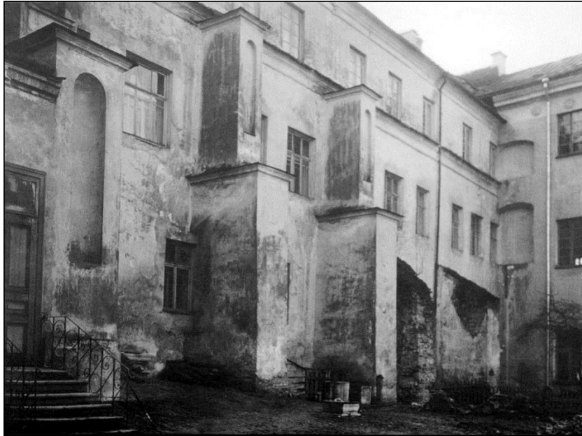
Południowe skrzydło Dziedzińca Sarbiewskiego z widocznym złym stanem elewacji. Fotografia Jana Bulhaka z 1913 r.
