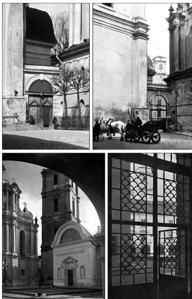
Brama w przejściu na Dziedziniec Skargi od strony ulicy Świętojańskiej. Po lewej stronie na górze dawna drewniana brama, po prawej nowa ażurowa z kutego żelaza na fotografii z ok. 1930 r.
