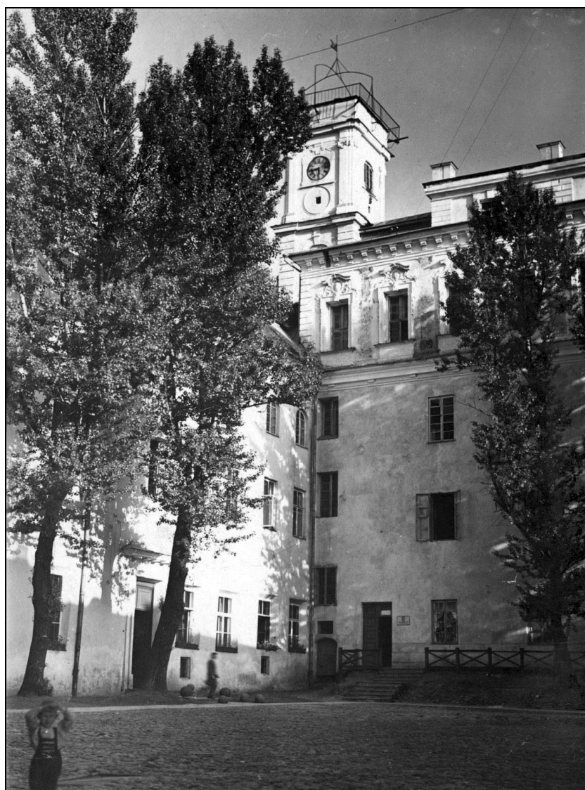
Skrzydło z budynkiem biblioteki i dawnego obserwatorium astronomicznego. Widoczne wejście do archiwum państwowego (tablica). Fotografia z ok. 1928 r. elewacje przed remontem. Fotografia Antoniego Skurjata (Źródło: AAN, 109/2.1/223/40).
