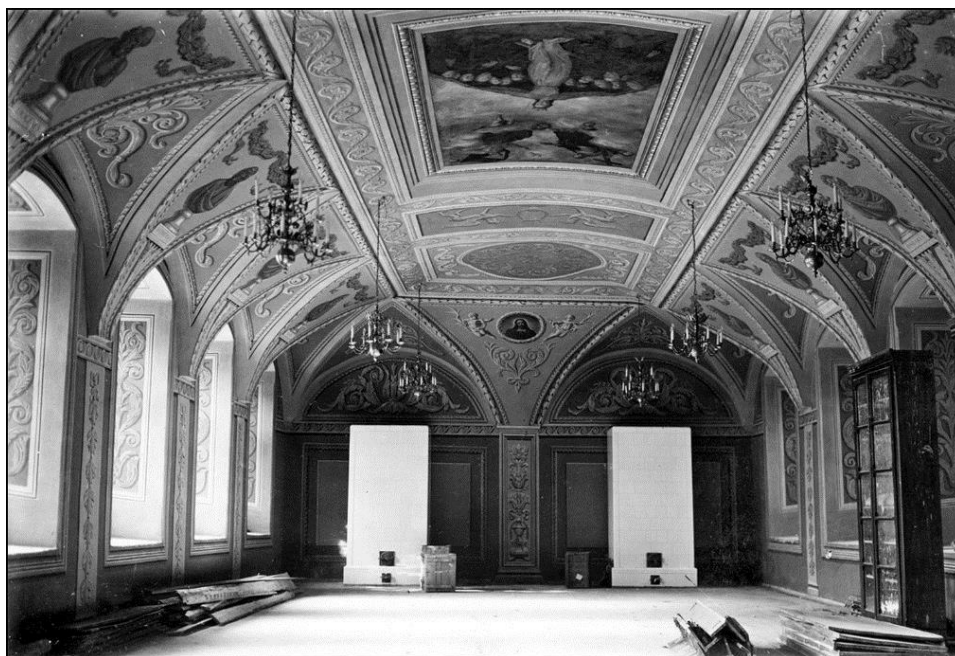
Dawna aula uniwersytecka (Sala Smuglewicza), po restauracji malowideł przez Jerzego Hoppena w 1929 r. Widoczne rozebrane rusztowania, a sala jest przed umeblowaniem. Fotografia Antoniego Skurjata (Źródło: AAN, 109/2.1/223/39).
