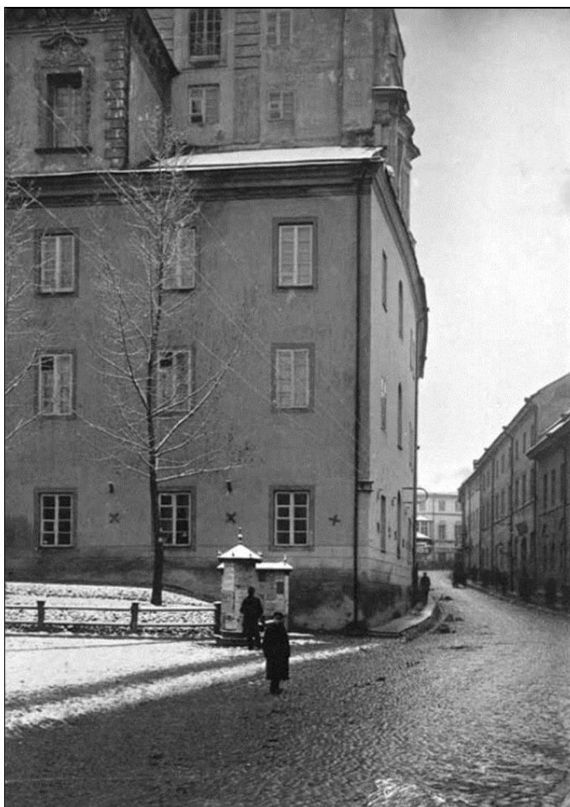
Ulica Dworcowa (później Uniwersytecka) na fotografii z ok. 1899 r. Po lewej narożnik budynku uniwersyteckiego. (Źródło: VUB RS, F82-1637, nr 51).
