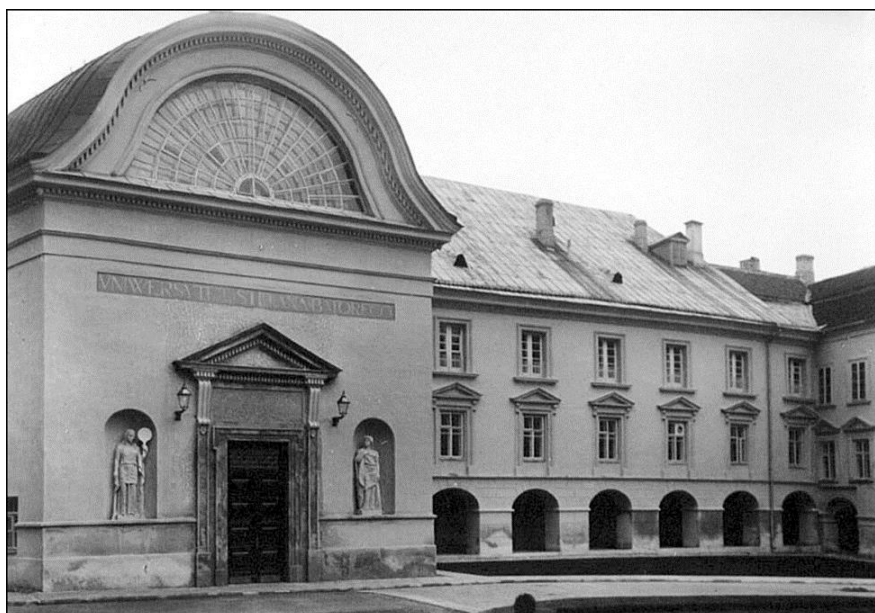
Południowe skrzydło Dziedzińca Skargi. Fotografia Józefa Łozińskiego z 1929 r., wykonana w trakcie trwających prac remontowych, kiedy nie było jeszcze jednej z tablic nad wejściem do budynku auli. (Źródło: Pocztówka z 1930 r.).
