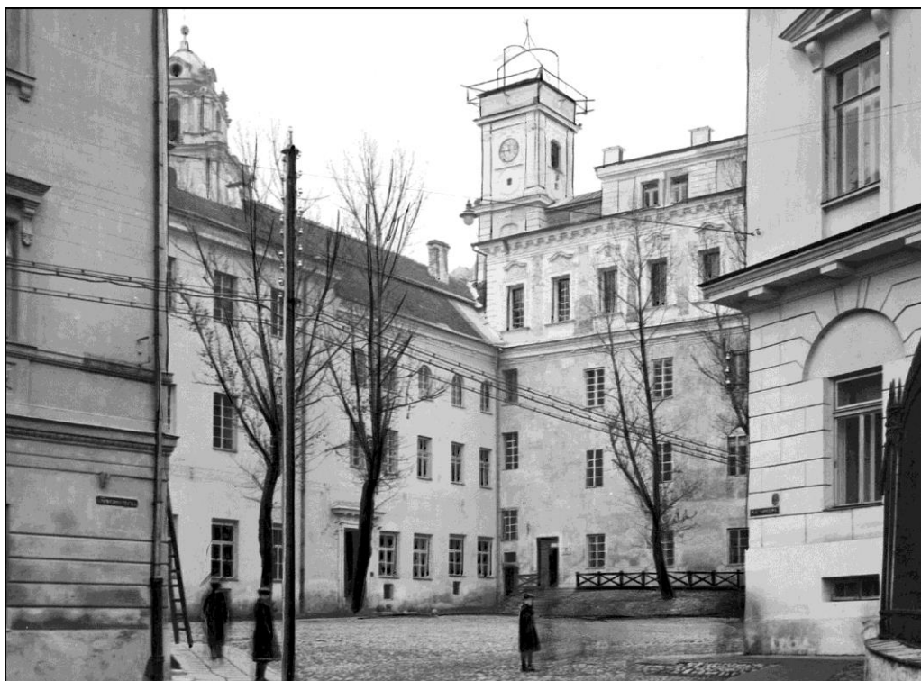
Skrzydło z budynkiem biblioteki i dawnego obserwatorium astronomicznego. Widoczne wejście do archiwum państwowego. Fotografia z 1927 r., elewacje przed remontem. (Źródło: NAC, sygn. PIC_1-N-3466).
