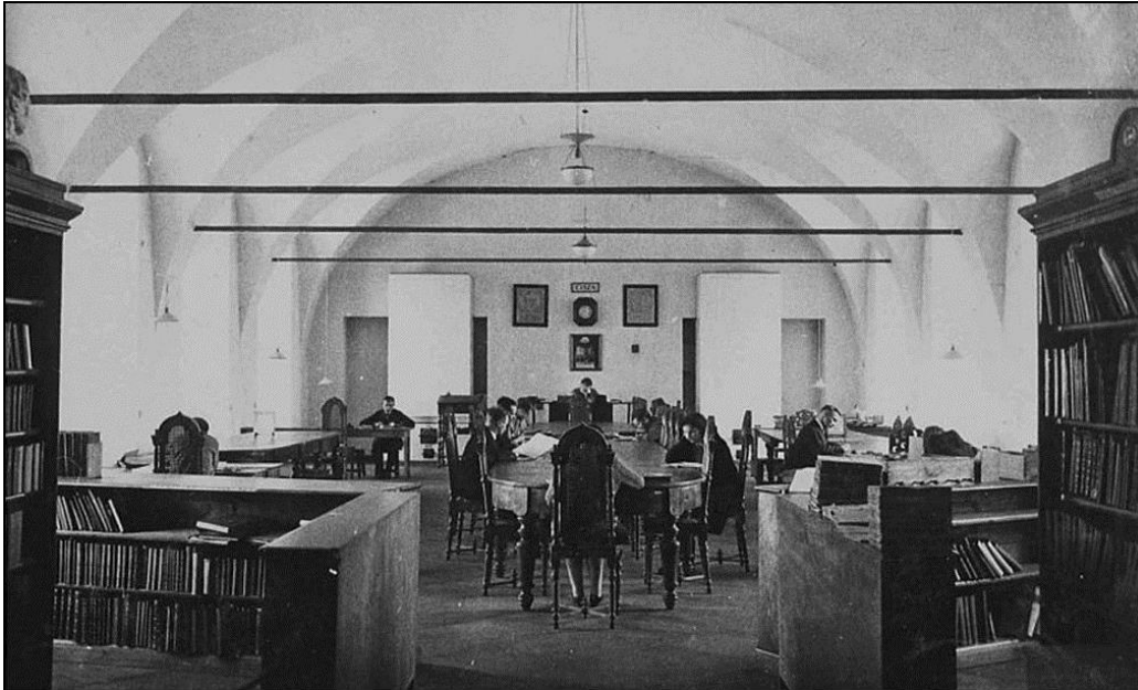
Czytelnia Uniwersyteckiej Biblioteki Publicznej w sali na I piętrze gmachu bibliotecznego. Widoczne kotwy spinające łuki sklepień, a przy końcowej ścianie nie ma już schodów do górnej sali. Fotografia J. Bułhaka z 1930 r.
